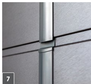
Avstandsbraketter med en trygg fasong, noe som sikrer bedre tetthet.
